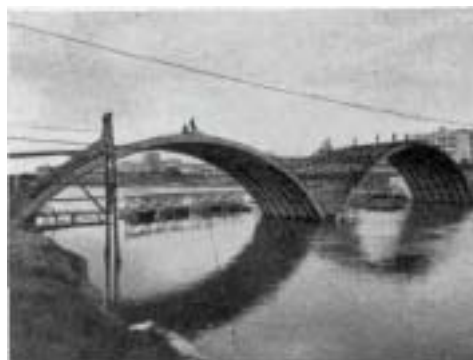
Preparazione gettata dei volti della 1ª e 2ª arcata
