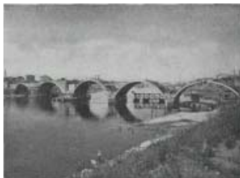
Veduta generale delle 5 arcate del ponte ad acque basse
