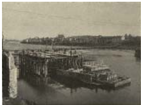
Bacino per la costruzione dei cassoni in c.a. alveolari
